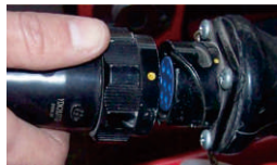
Sambungkan kabel dengan box kelistrikan
